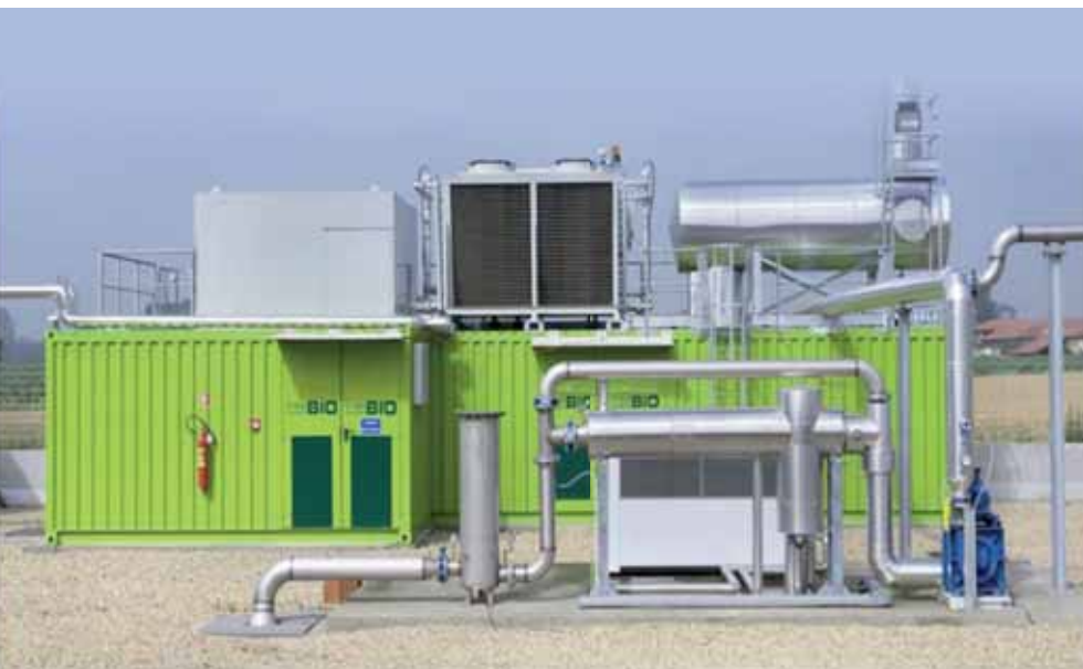
Sistema di trattamento e deumidificazione biogas composto da filtro, Hypercool BioEnergy, Hypersep BioEnergy e Hyperchill BioEnergy.
