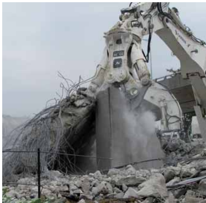
Calcolo FEM su cesaia idraulica e modello HC 120 del peso operativo di 12 t.
