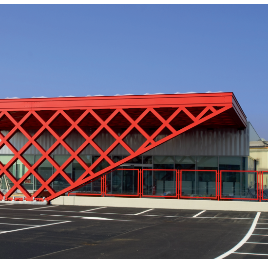
Il nuovo ingresso polifunzionale della sede principale di Metra, a Rodengo Saiano, realizzata secondo criteri di ecosostenibilità.
