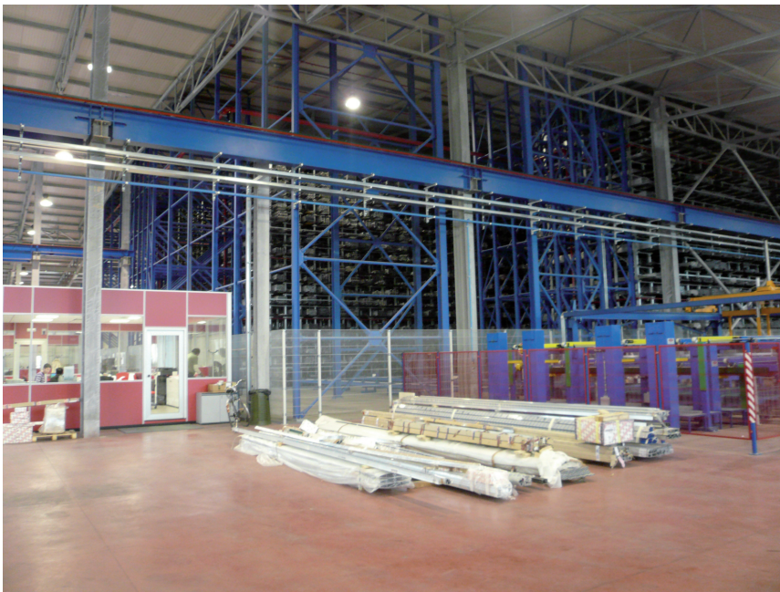
Il nuovo magazzino automatico installato nel polo logistico della sede Metra di Rodengo Saiano.
