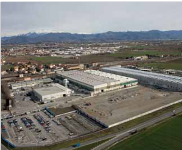
Stabilimento Eural Gnutti di Rovato, in provincia di Brescia.
