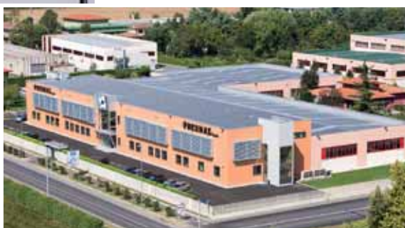
Il nuovo stabilimento di Pneumax.
