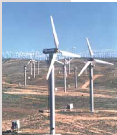
Pale eoliche incollate con adesivi epossidici Araldite.
