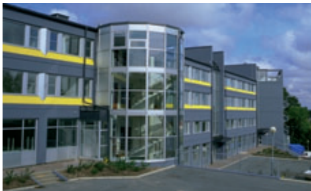
Il quartier generale di Piab AB a Stoccolma.
