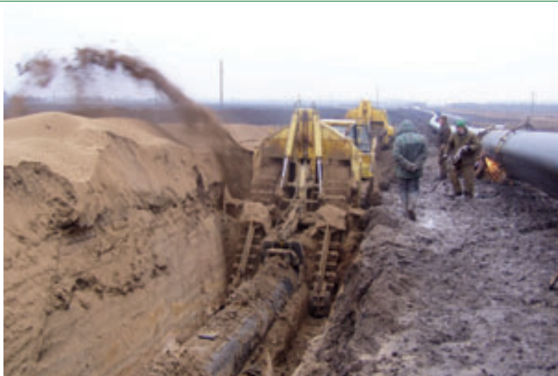
2. La parte superiore e quelle laterali della pipeline vengono quindi scoperte nella seconda operazione, svolta dal modulo Mvt.
