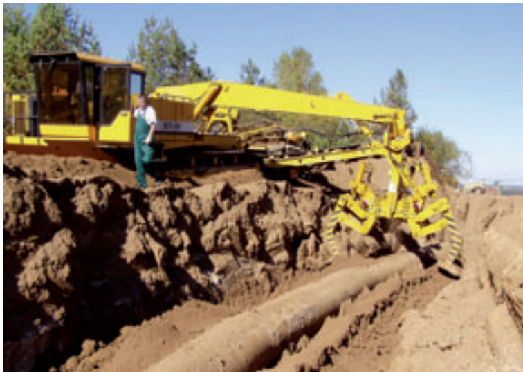
3. L'unità macchina MP provvede a riempire nuovamente lo scavo.
