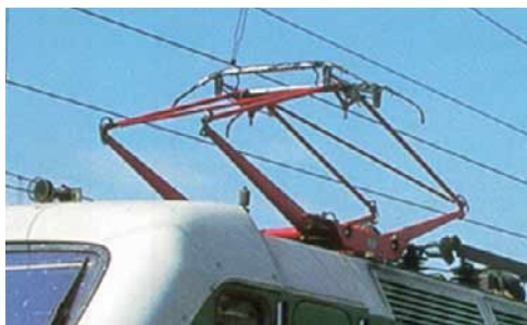
1. La captazione di corrente elettrica a mezzo dei contatti striscianti del pantografo in contatto con la linea aerea (catenaria.)
