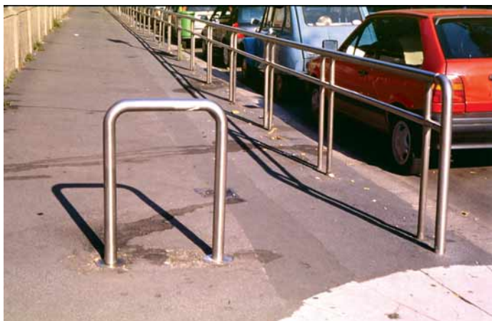
I. Da circa vent'anni il Comune di Milano pone archetti di tubo saldato d'inossidabile austenitico Aisi 304 a protezione dei marciapiedi dal posteggio abusivo e barriere di tubi saldati, sempre di Aisi 304, a protezione di studenti all'uscita dalle scuole e di pedoni lungo le strade più trafficate.
