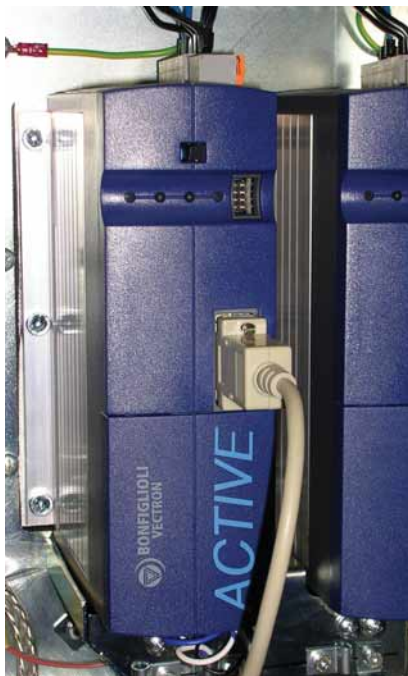
Montato su un dissipatore cumulativo al di fuori dell'armadio di comando: inverter Active di Bonfiglioli.
