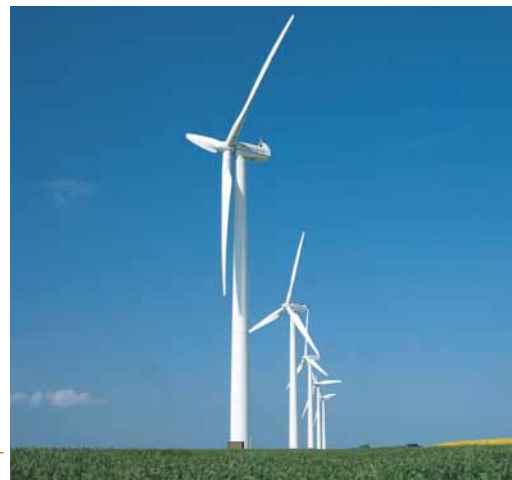
Un esempio dell'uso del bus di sistema degli inverter della famiglia Active di Bonfiglioli: calibrazione degli azionamenti navetta nei sistemi ad energia eolica.
