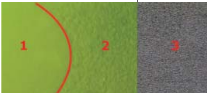
Figura 5 Si distinguono tre zone: 1) verniciatura che copre i picchi della sabbiatura 2) verniciatura che non copre i picchi della rugosità 3) zona sabbiata, non verniciata.
