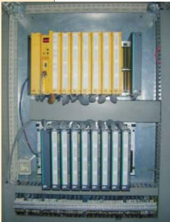
**L'armadio contenente il PLC di sicurezza per la gestione della pressa.**
