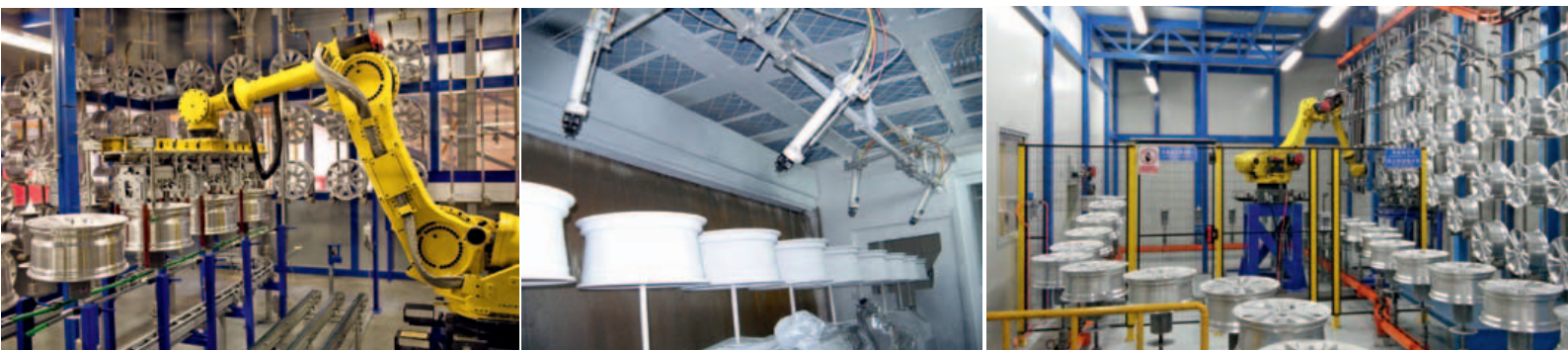
Un impianto di verniciatura delle ruote e alcuni particolari di fasi di lavorazione nell'impianto stesso.
