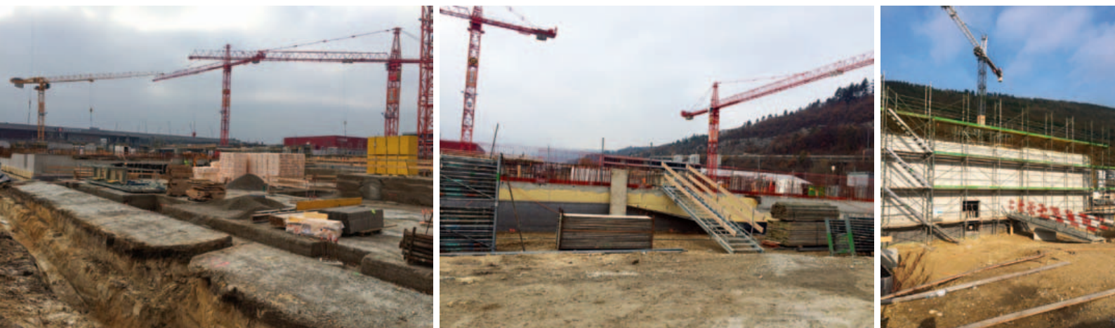
Una serie di immagini che riprendono le fasi di costruzione del nuovo stabilimento GF Machining Solutions in Biel.
