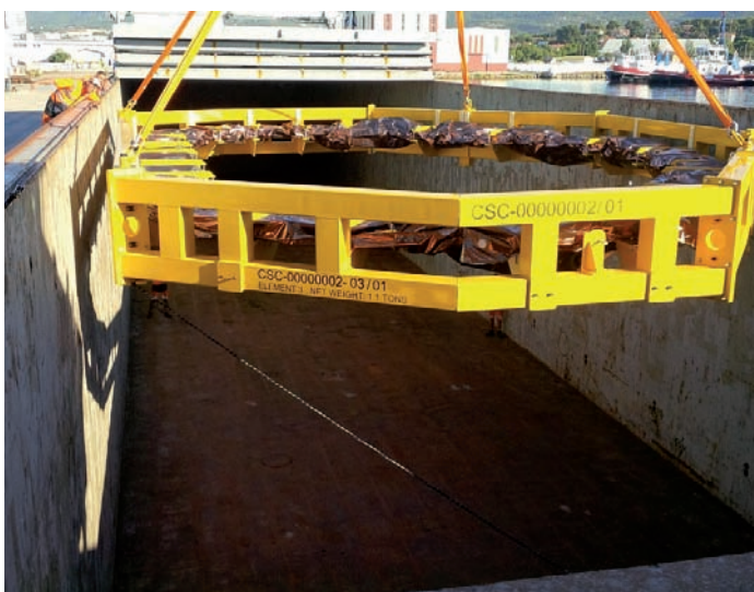
I radial plate sono componenti destinati a contenere e sorreggere il cuore di un reattore, la camera di fusione. Qui una fase di realizzazione e di trasporto.
