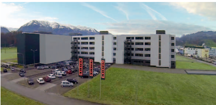
Ampliamento dello stabilimento produttivo Leister di Sarnen.
