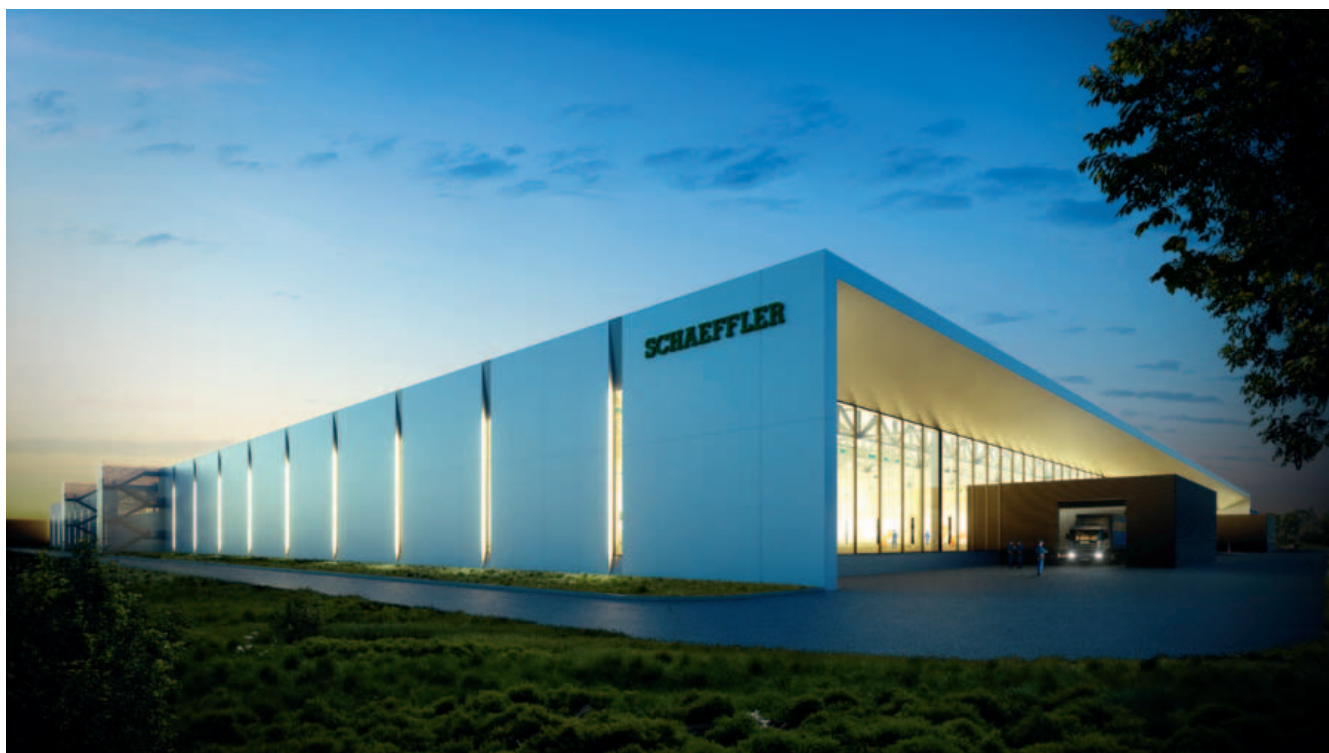
Questo è l'aspetto che avrà il primo 'Stabilimento del futuro' di Schaeffler che è in fase di costruzione a Xiangtan, Cina.
