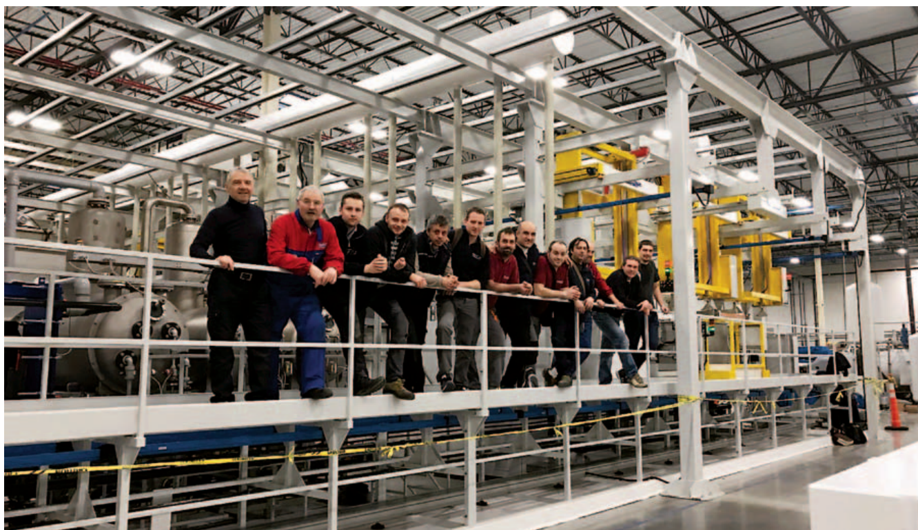
Ilmar, a eccezione della pneumatica e dei motori elettrici, realizza tutto internamente: lavorazioni meccaniche, parte elettrica e software.
