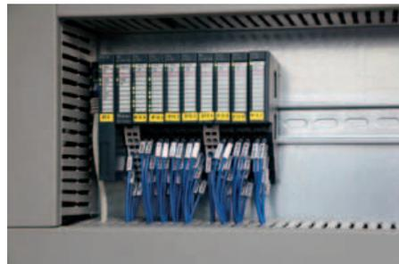
Moduli OpenRio SL utilizzati per la gestione dei 600 I/O dell'impianto.
