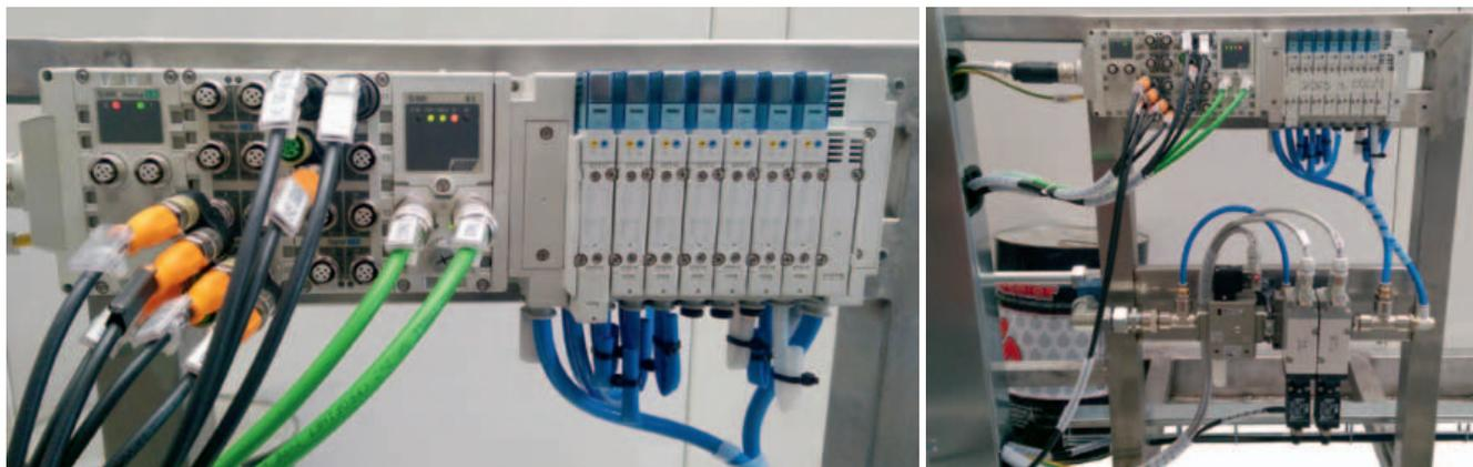
Manifold di valvole SY con nodo seriale EX600 di SMC. Manifold di valvole SY con nodo seriale EX600 e sotto avviatore progressivo serie EAV + valvola di sicurezza doppia serie VP744.
