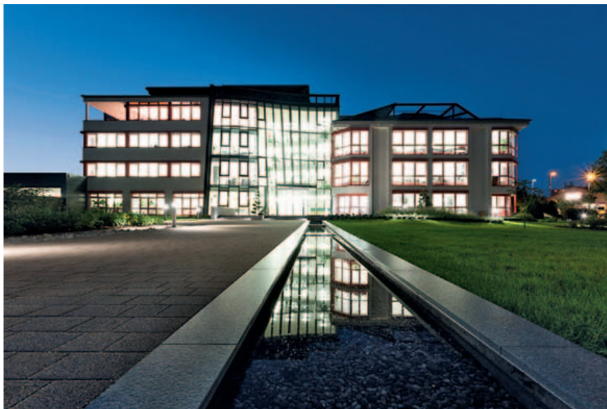
Headquarter di Hilscher, ad Hetttersheim, Francoforte.
